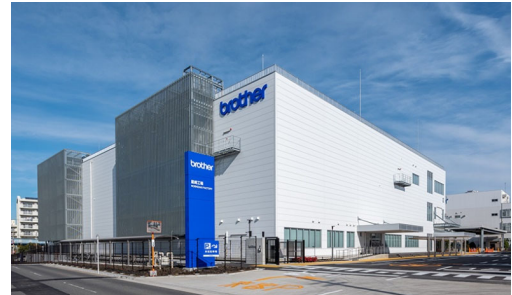
星崎工場 新工場棟（第13工場）
